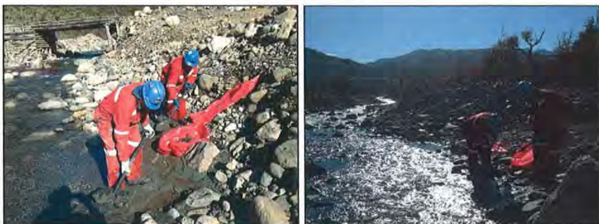
Figuras 8 y 9. Limpieza y retiro de relaves acumulados desde las orillas.
